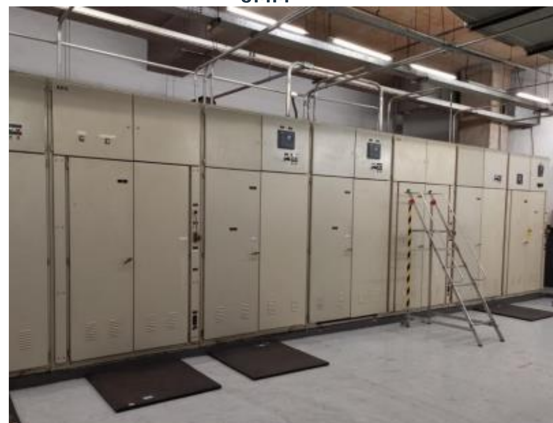
Retrofit no Disjuntor, Seccionadora e Relé de Proteção do Painel de Média Tensão 34,5kV – Subestação Principal – 5MM
