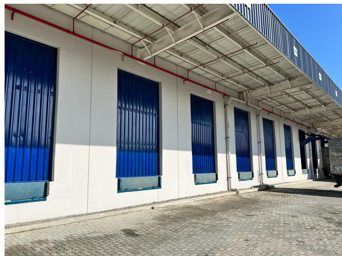
Foto 01 – docas e niveladoras finalizadas
