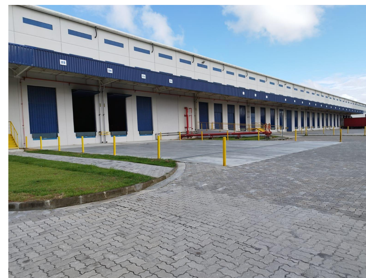
Foto 06 – ajuste de nível de docas e piso intertravado finalizados
