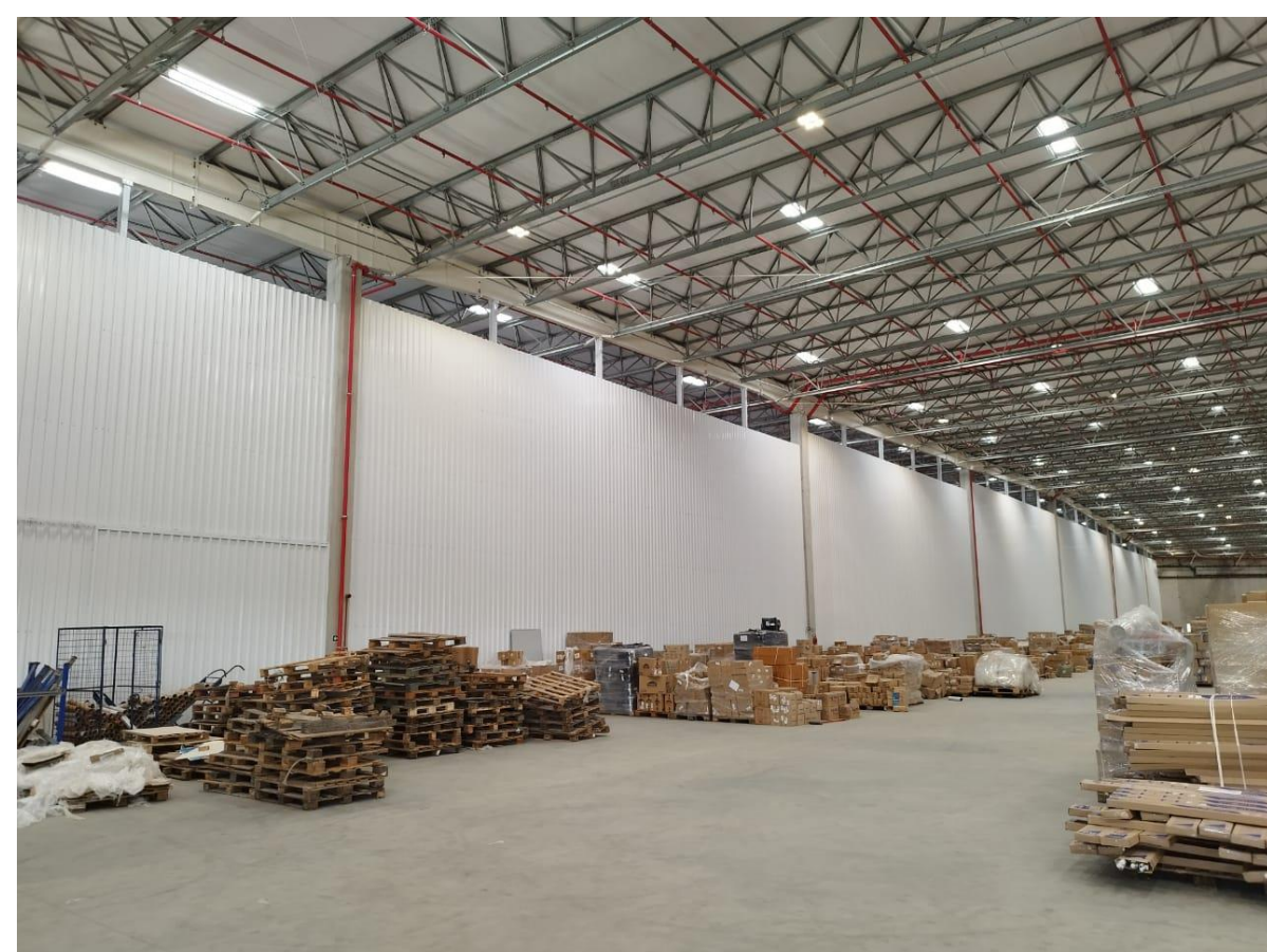
Foto 04 – divisória entre módulos
