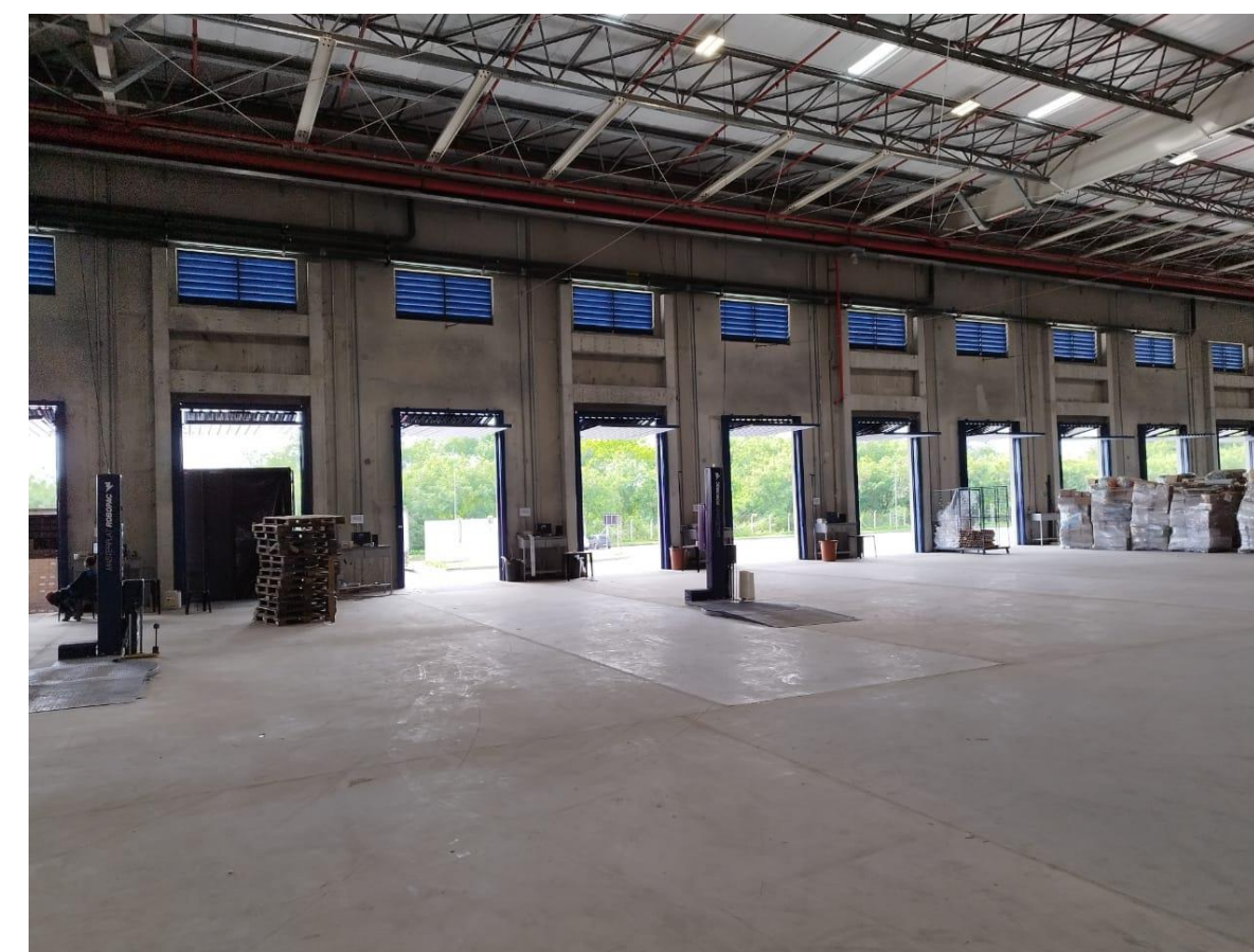
Foto 03 – docas do tipo Sider “fechadas” e em operação
