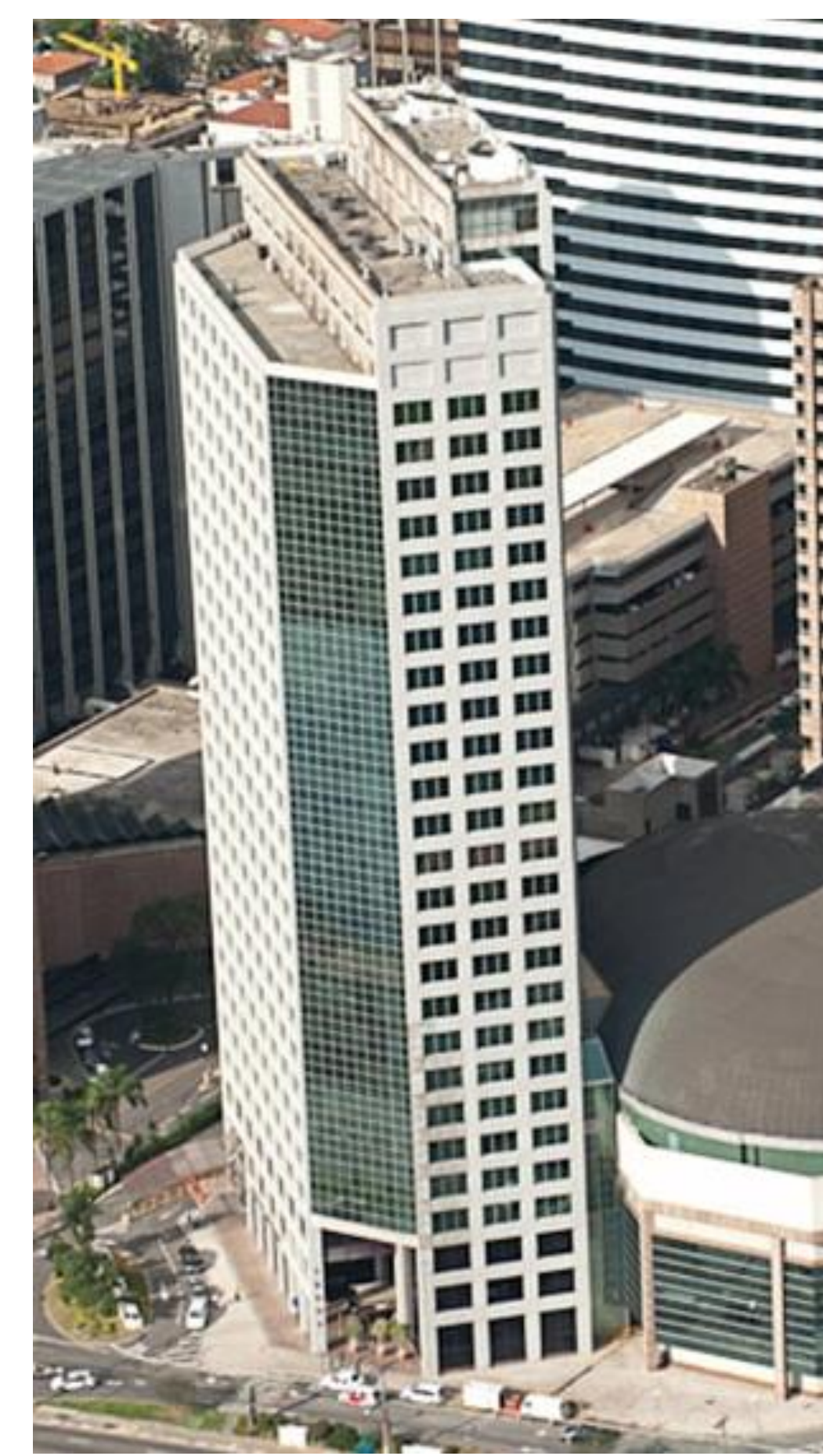
Torre de Escritórios
