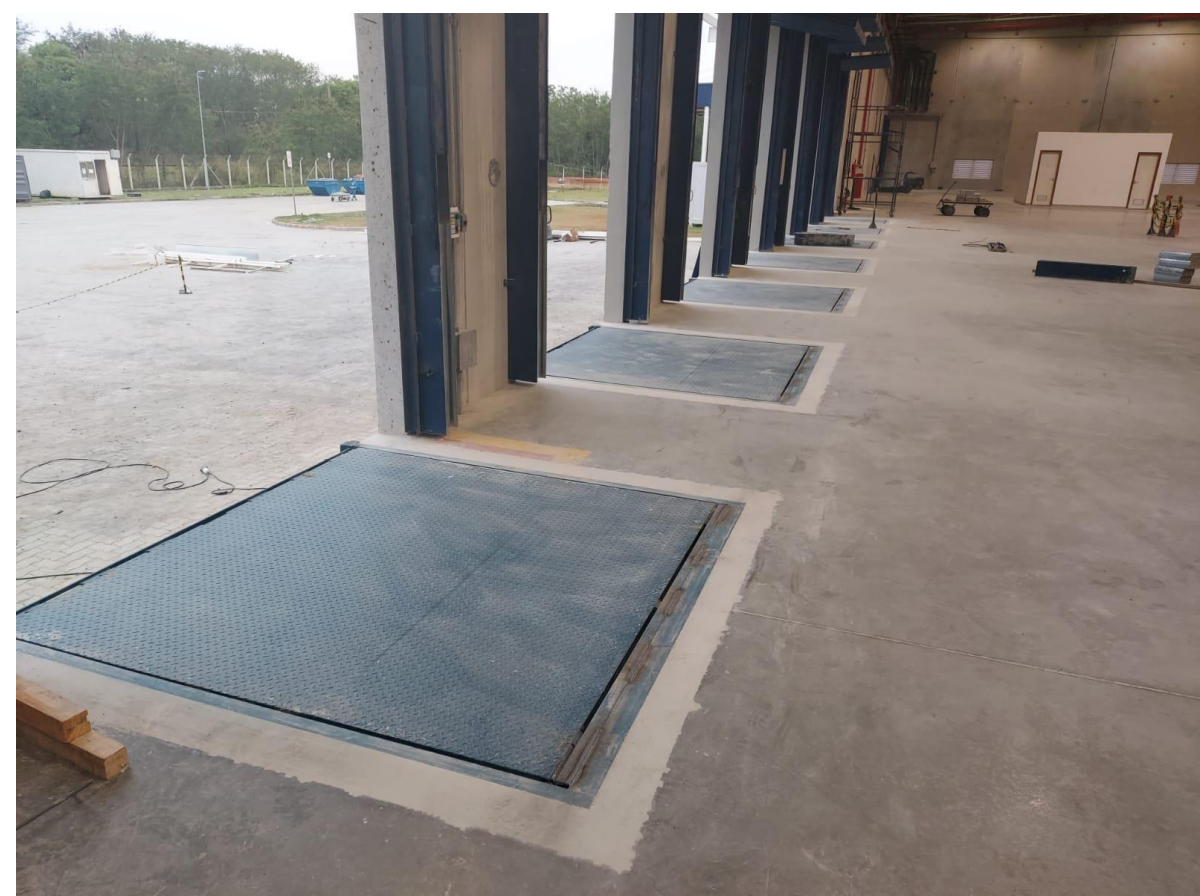
Foto 01 – finalização de instalação de niveladoras automatizadas
