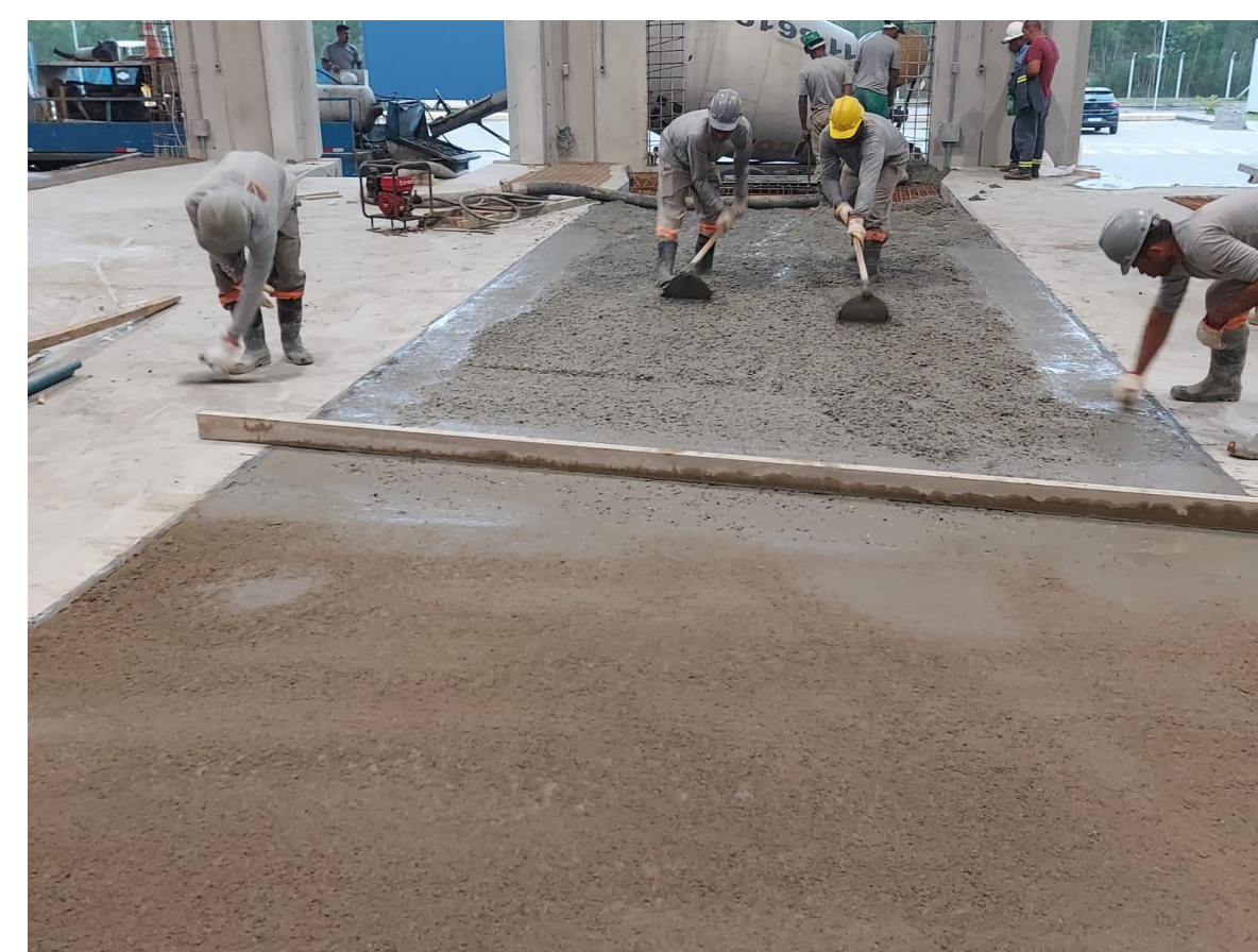
Foto 03 – concretagem para finalização da conversão das docas do tipo Sider em docas padrão
