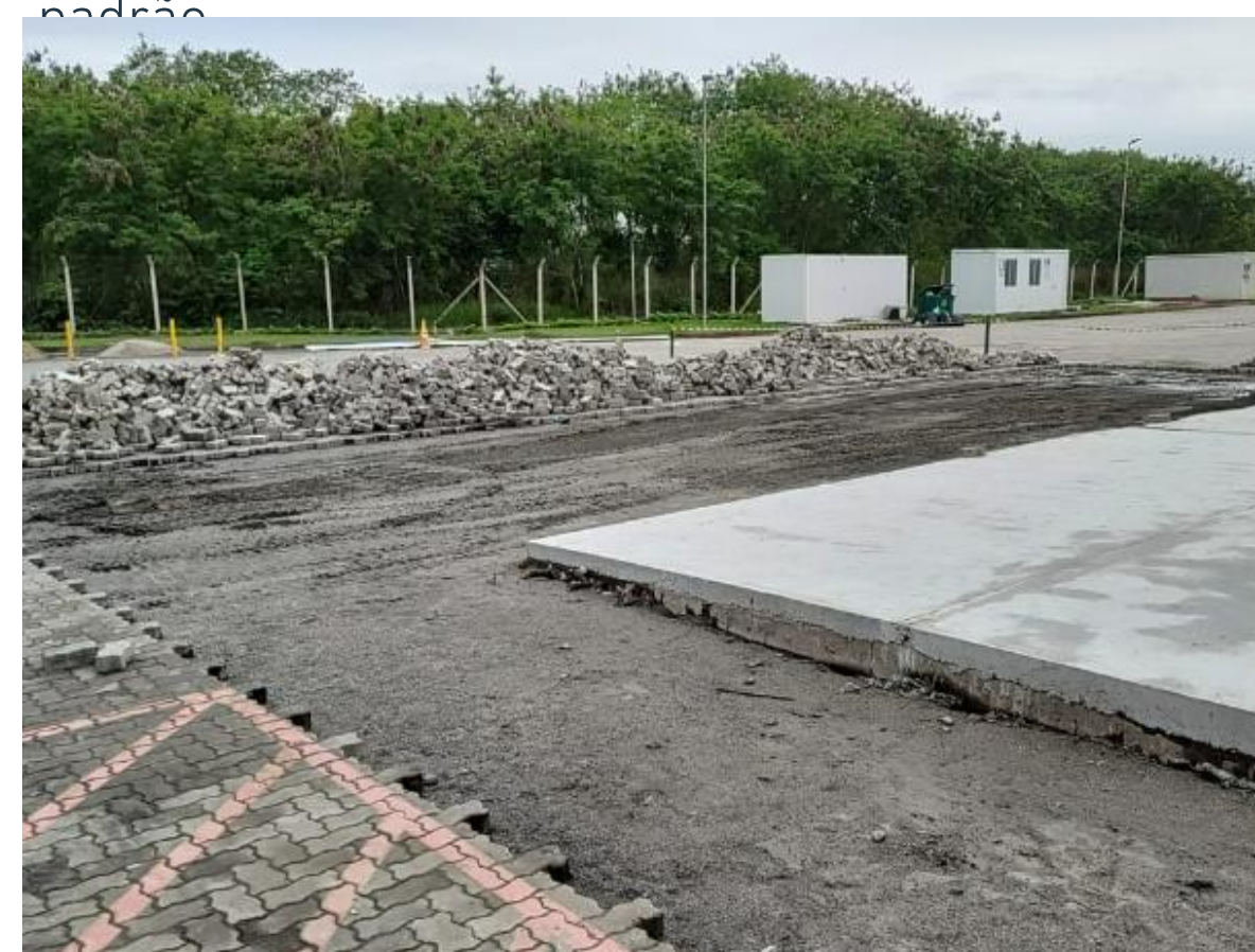
Foto 06 – ajustes finais no piso intertravado na área onde houve ajuste de nível das docas existentes
