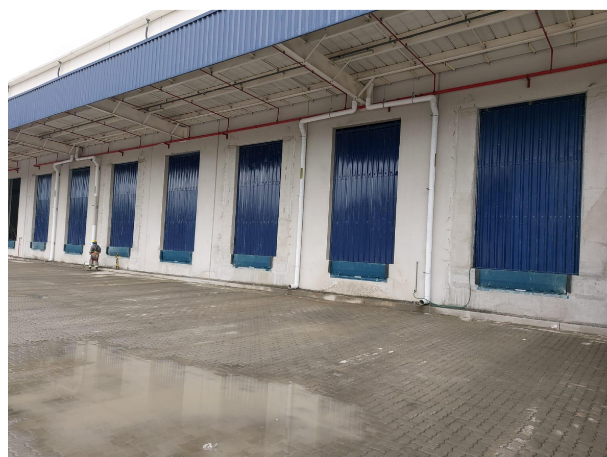
Foto 02 – finalização de fechamento das portas das docas
