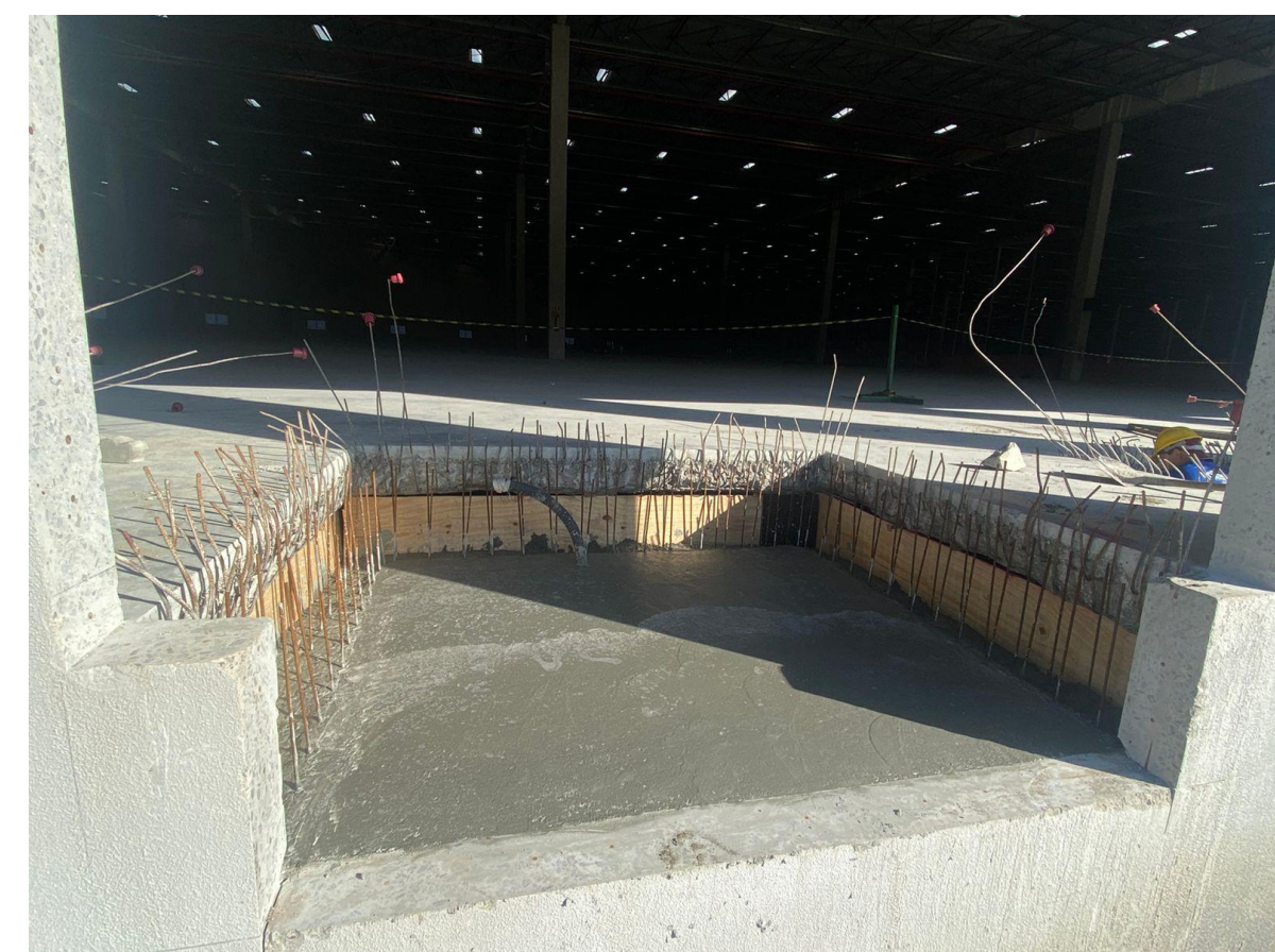
Foto 05 – execução de pisos dos nichos das niveladoras das novas docas
