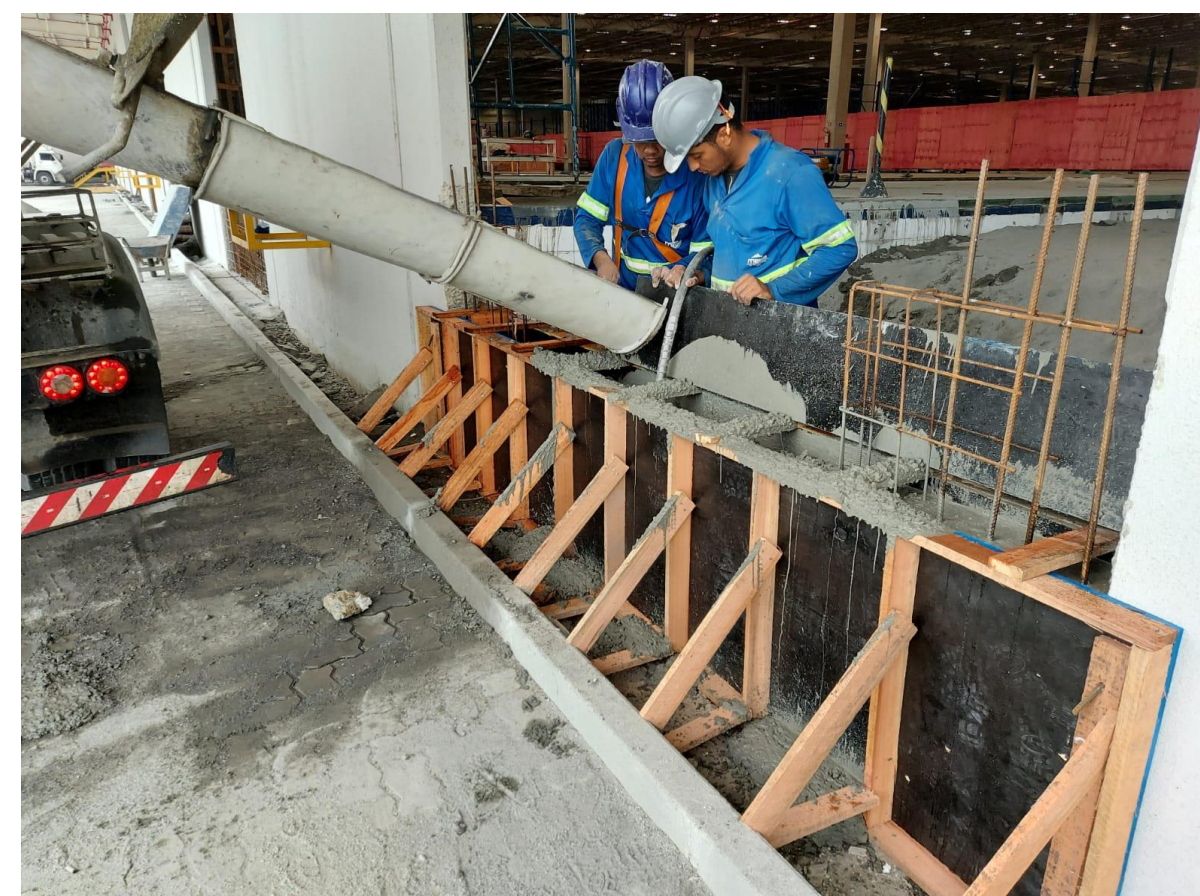
Foto 02 – execução de paredes de contenção nas antigas siders
