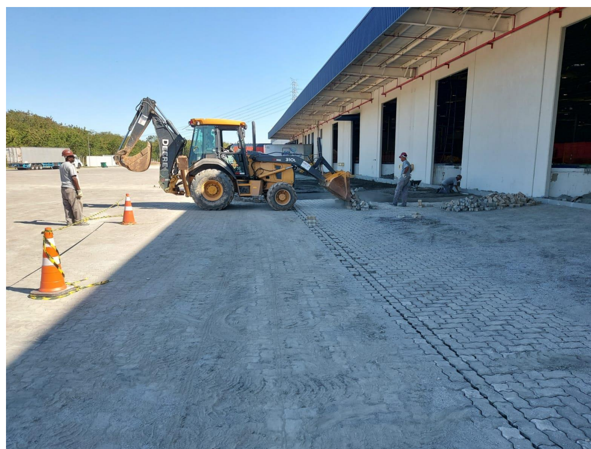
Foto 06 – ajustes finais no piso intertravado na área das docas
