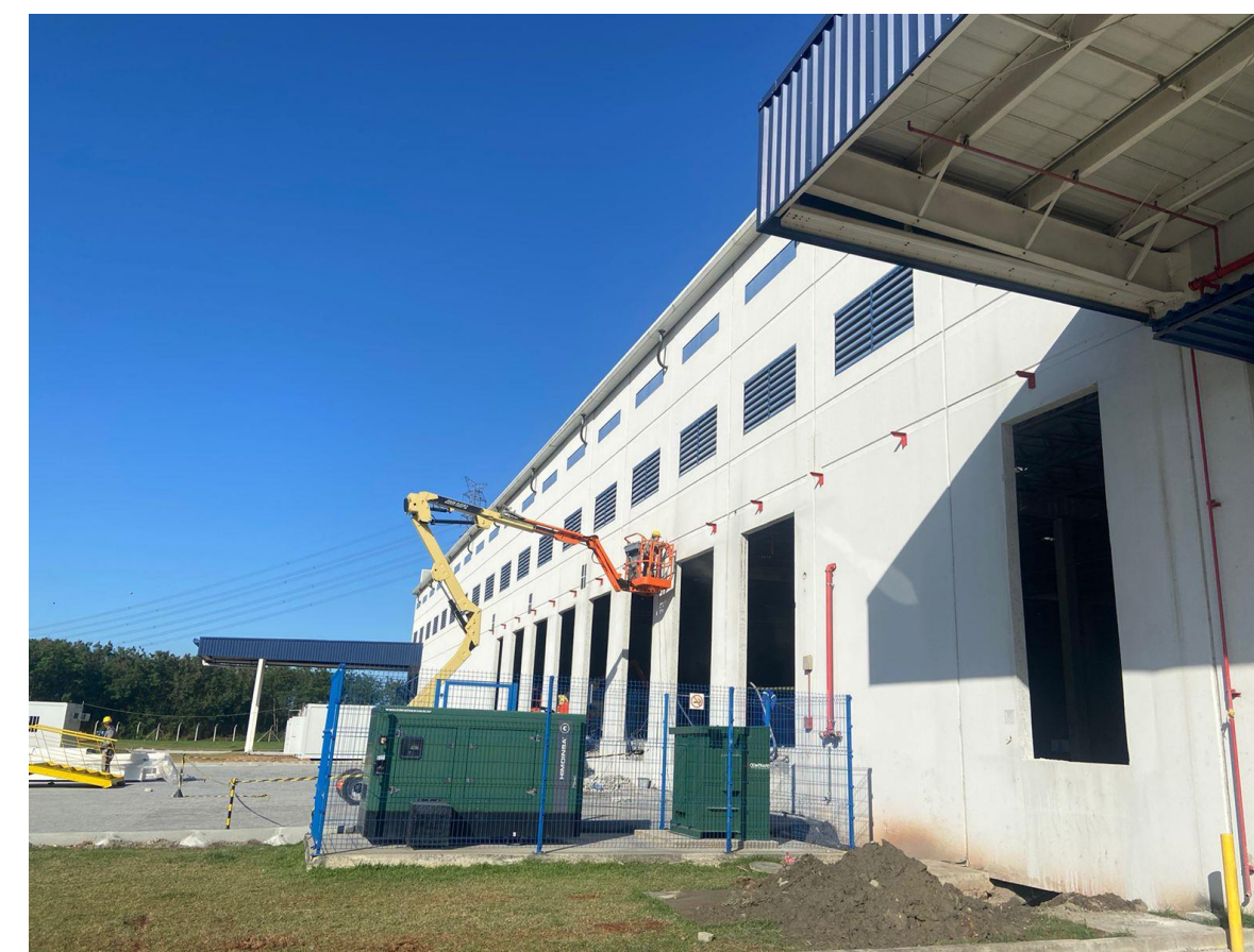
Foto 03 – instalação de insertos de espera para vigas da marquise metálica
