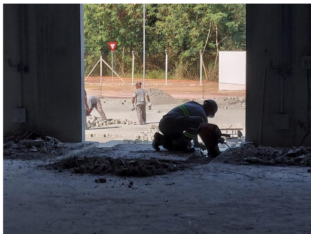
Foto 01 – corte e demolição de piso para novas niveladoras
