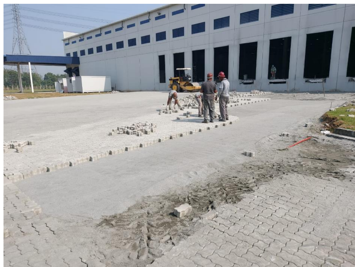
Foto 04 – finalização de ajuste de greide do pátio das novas docas
