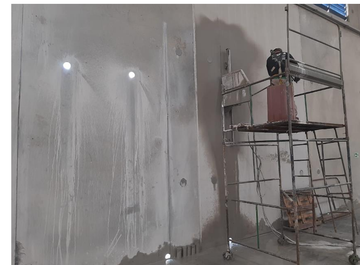
Foto 03 – corte nos painéis tilt-up
