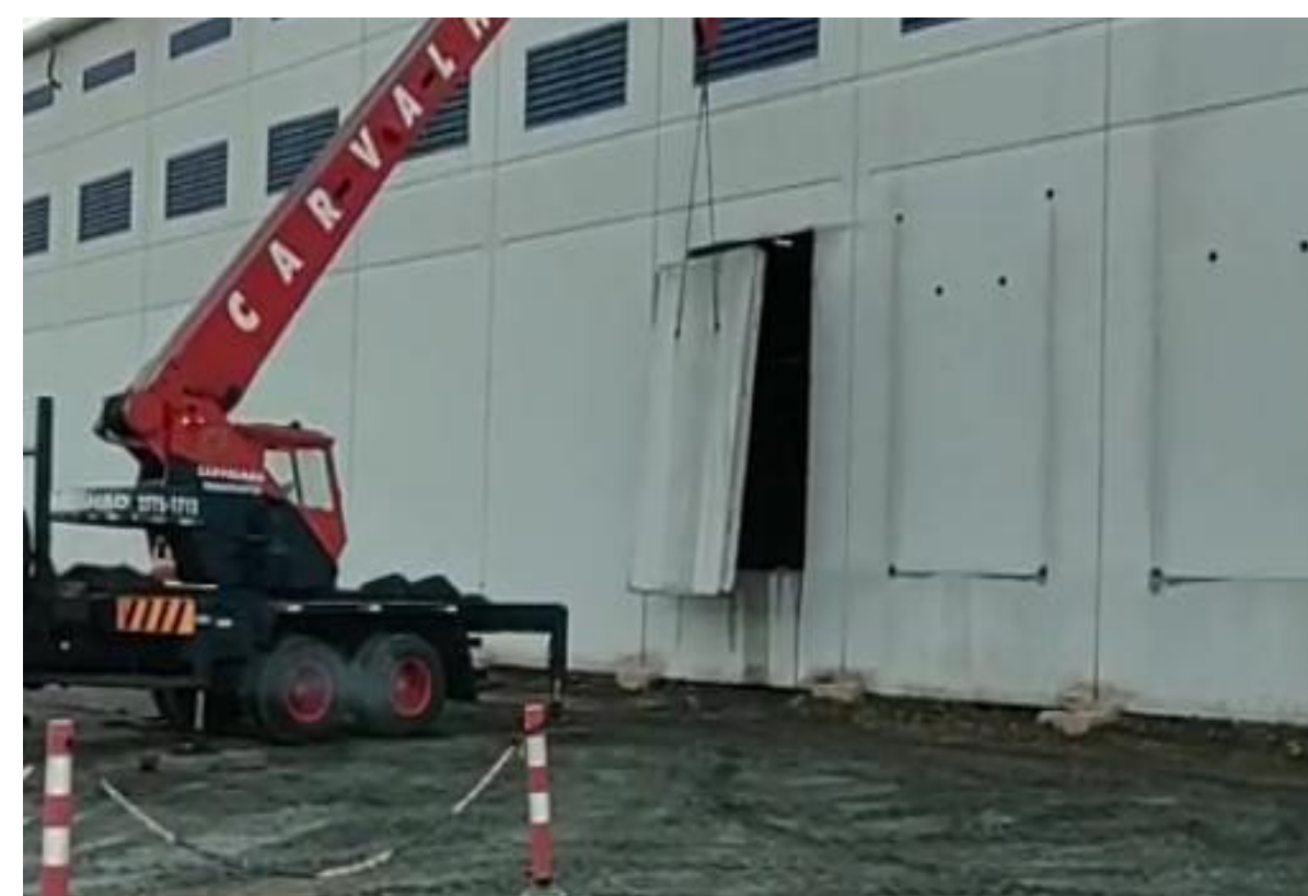
Foto 04 – abertura painéis tilt-up (novas docas)
