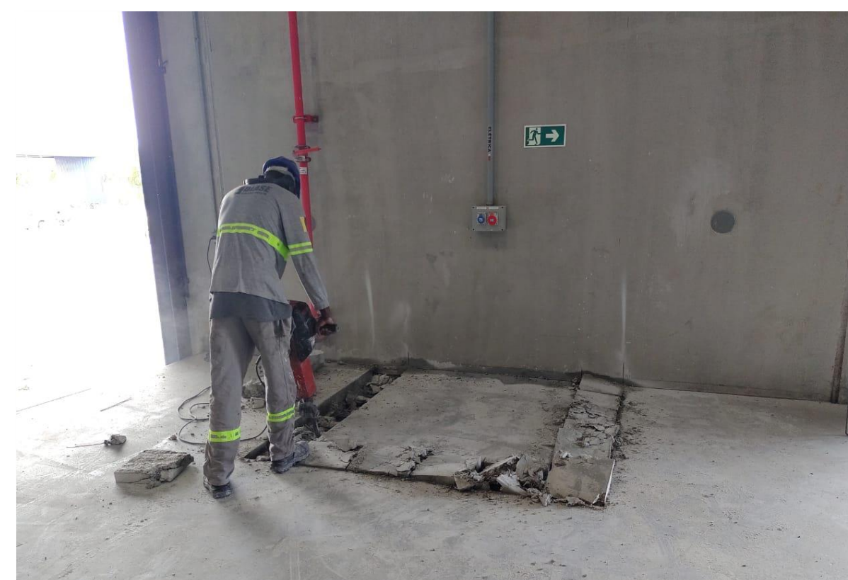
Foto 05 – corte e demolição do piso para execução de nichos de niveladoras
