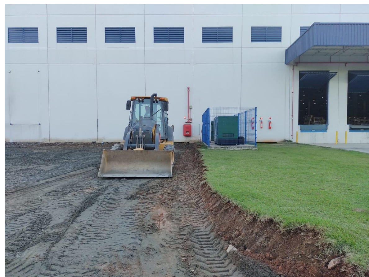
Foto 01 – remoção do piso intertravado externo para nivelamento das novas docas
