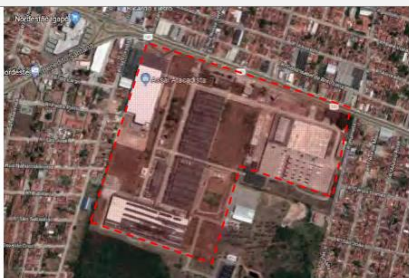
Garantia: imóvel em São Gonçalo do Amarante/RN
