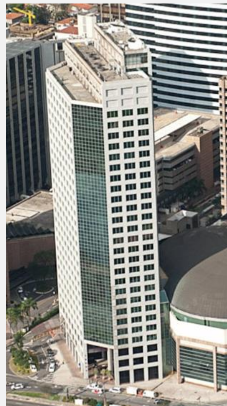
Torre de Escritórios
