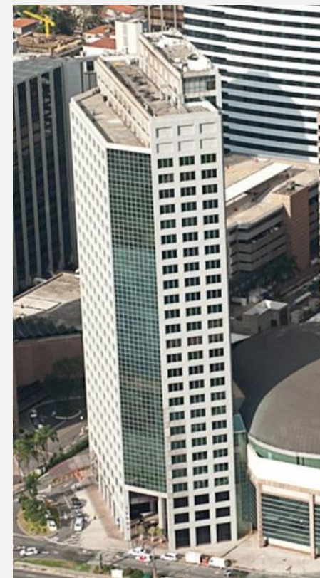
Torre de Escritórios
