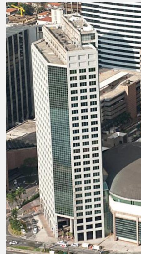
Torre de Escritórios
