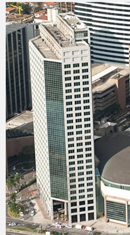
Torre de Escritórios
