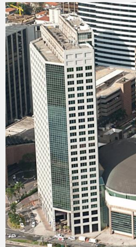
Torre de Escritórios
