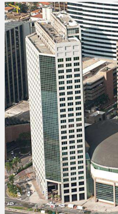
Torre de Escritórios
