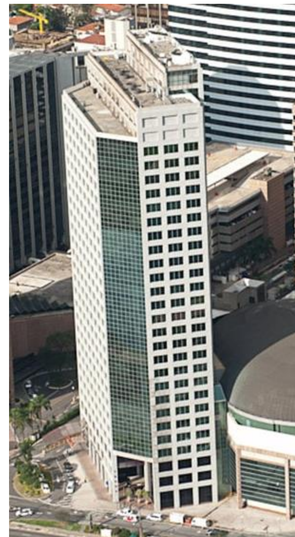
Torre de Escritórios
